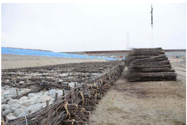
写真 5 粗朶沈床施工中の様子
