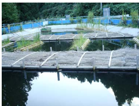
写真 3：沈殿池 3 層目のようす
