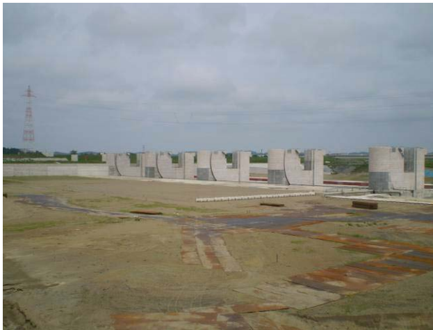
写真 3 新可動堰上流側の様子
