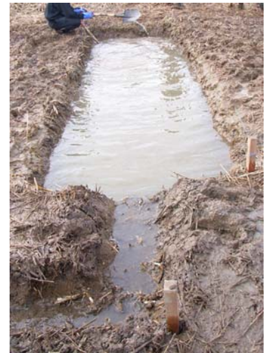
図 2 施工した沈砂池
