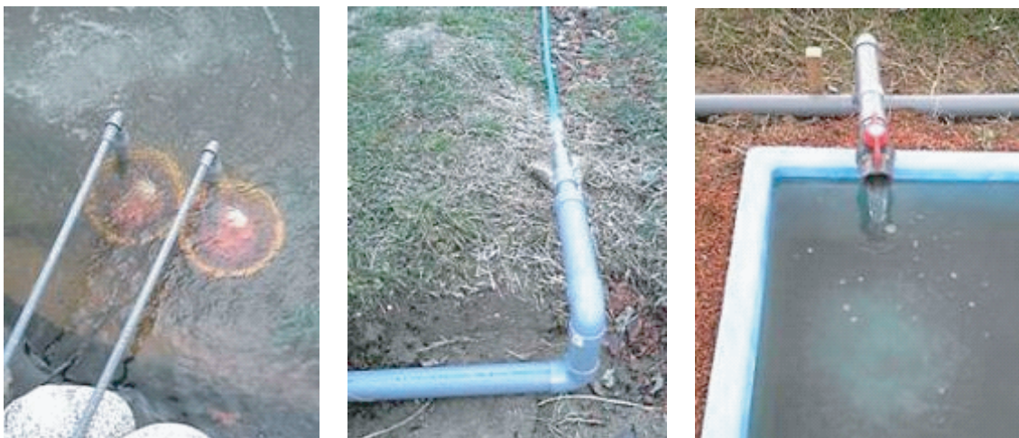
写真 2 池から排水路までの接合部分
