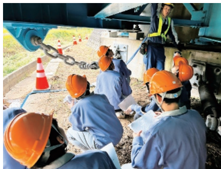
橋梁の点検実習(浦田橋、県道59号高松津幡線)
