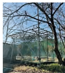
一塁側ブルペンへの屋根の設置
