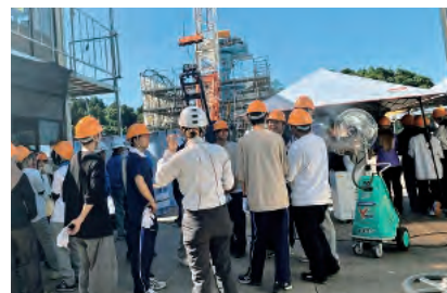
ニューマチックケーソン（七尾市国分町）の現場見学の様子（2025年7月28日）
