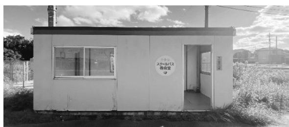
写真3 七尾市仮設待合所(近景)
