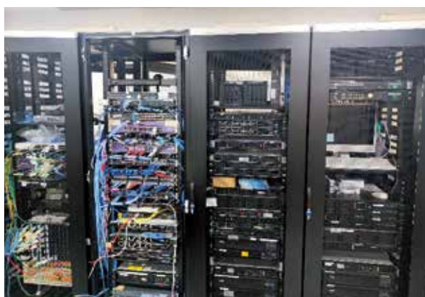
サーバ室に設置された基幹サーバやネットワーク機器
