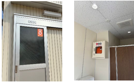
陸上競技場男子トイレ内
