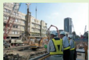
前田建設工業の地下鉄 オペラハウス駅工事現場の見学
