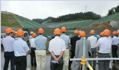
次期廃棄物埋立場埋立地整備工事現場
